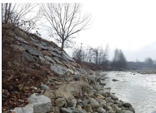
Figura 13 Scogliera esistente a sud del ponte sulla Sp222 (vista da nord )
